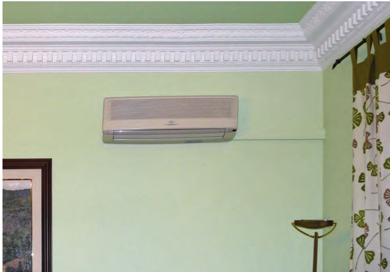
Rehabilitación de viviendas
