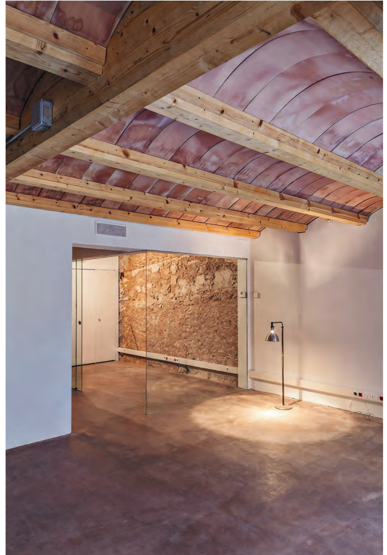
Espacios de trabajo: rehabilitación de oficina
