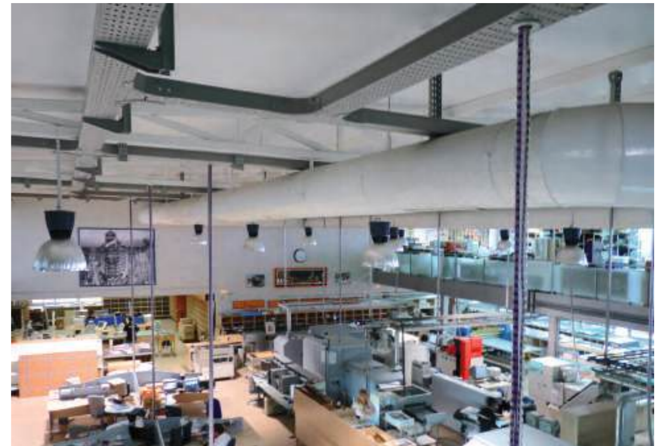
Nave industrial: oficina
