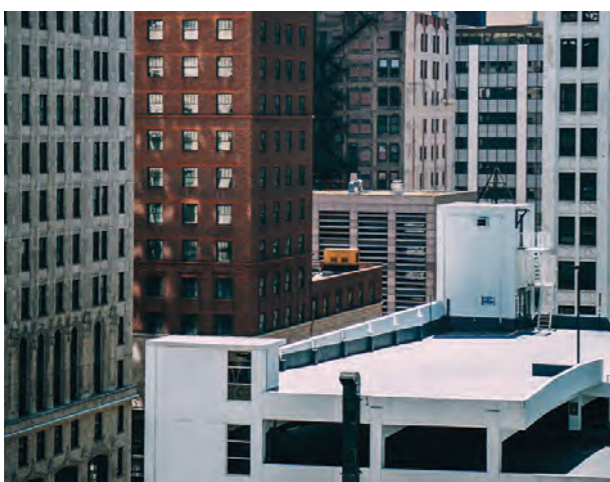
Instalaciones en azoteas
