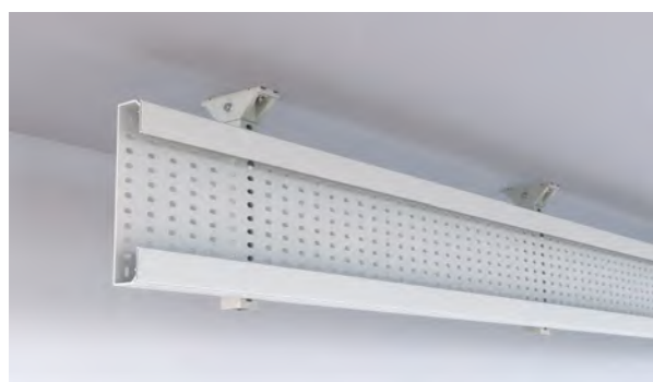
Montaje desde techo
