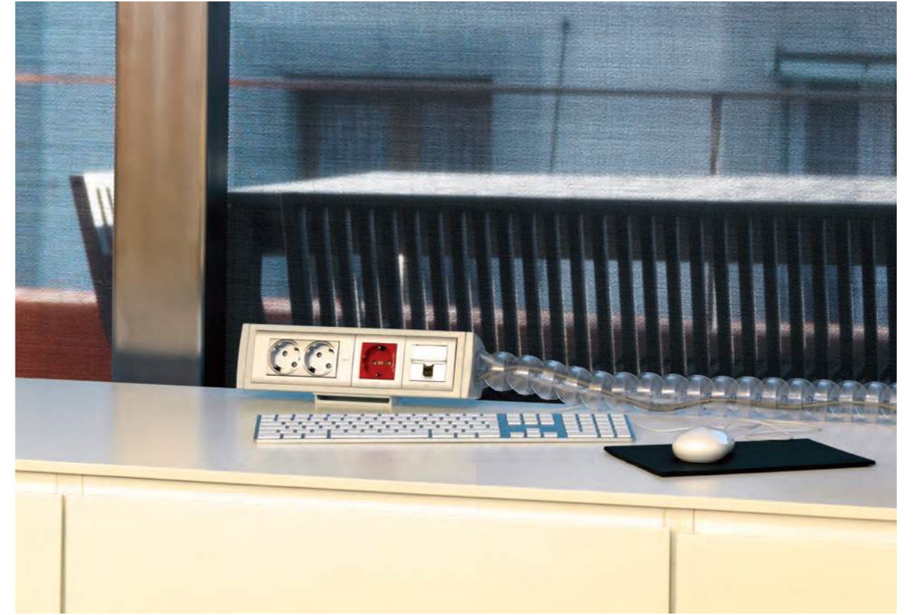
Puesto de trabajo: oficina
