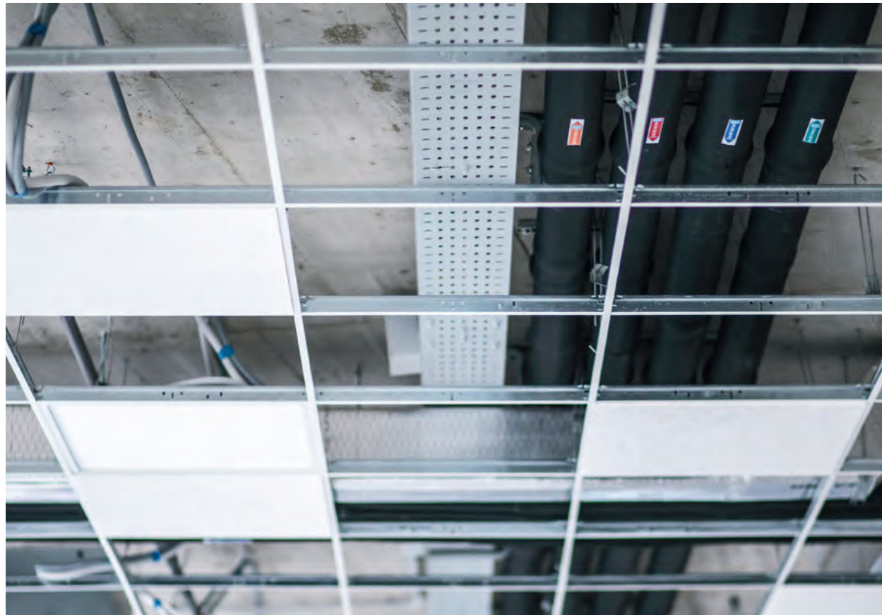
Espacio de trabajo: oficina
