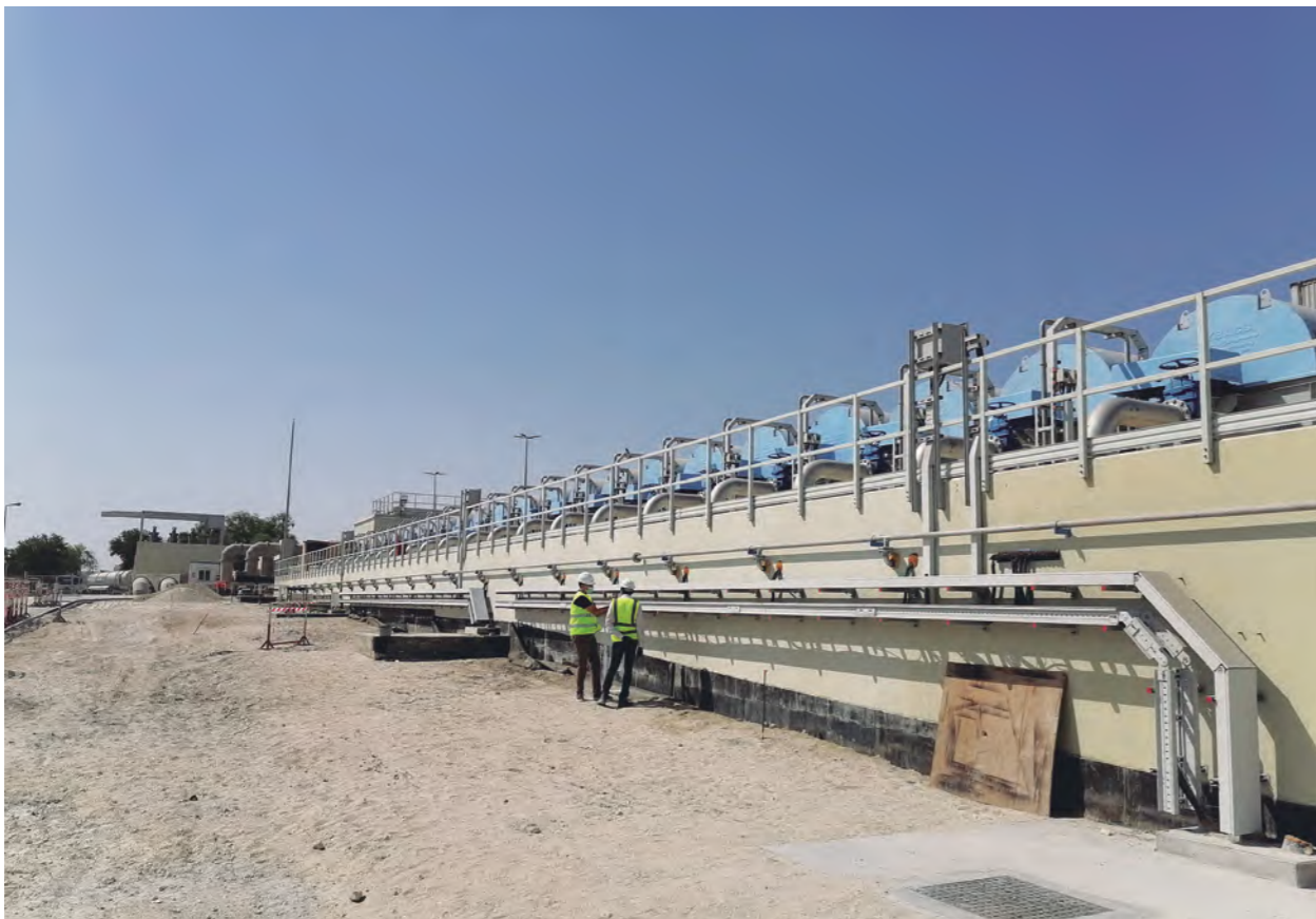
Tratamiento de aguas: EDAR
