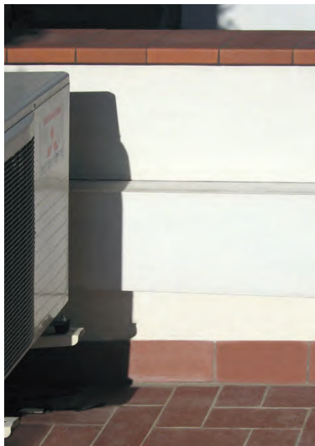
Rehabilitación de viviendas
