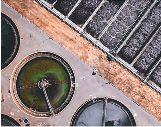
Tratamiento de aguas
