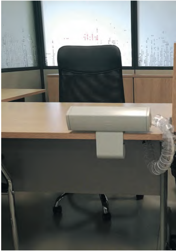
Puesto de trabajo: oficina
