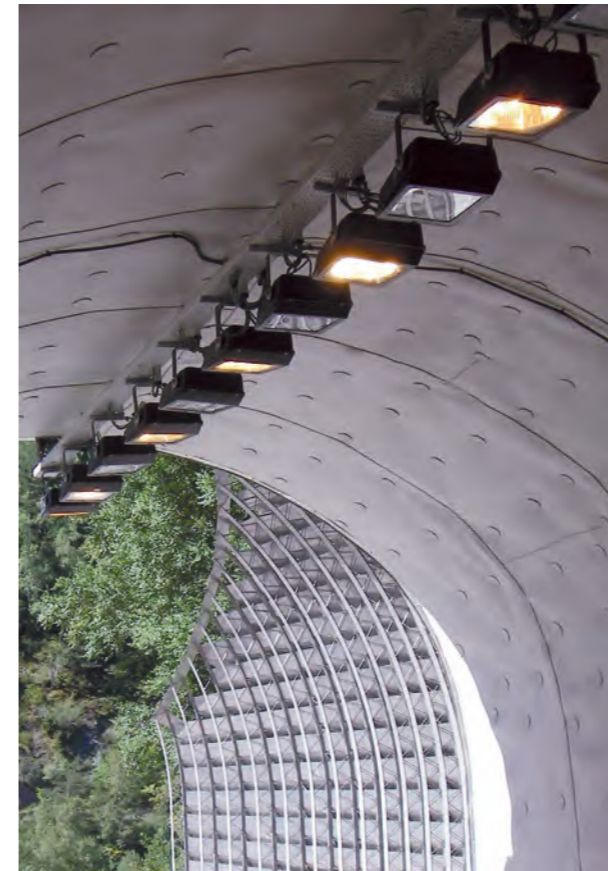
Infraestructura viaria: túnel
