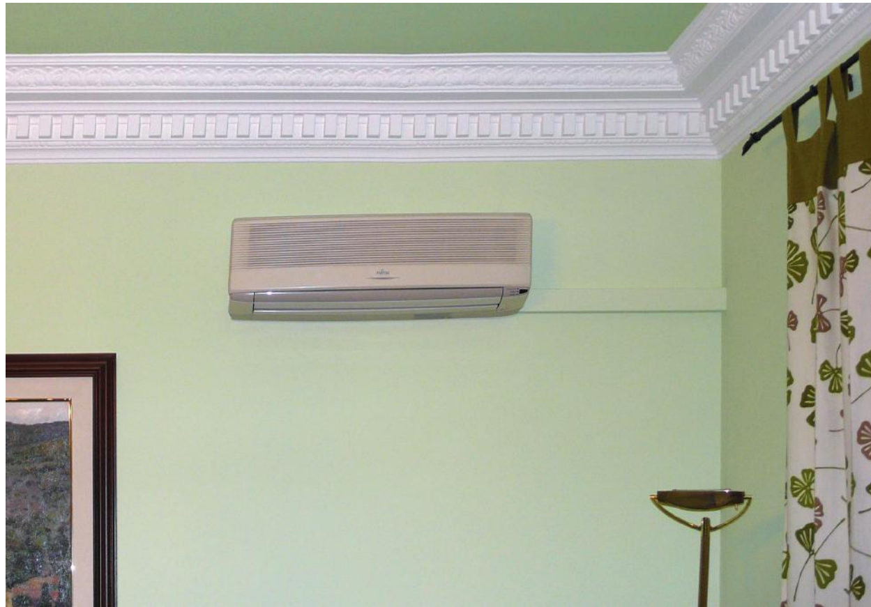
Rehabilitación de viviendas
