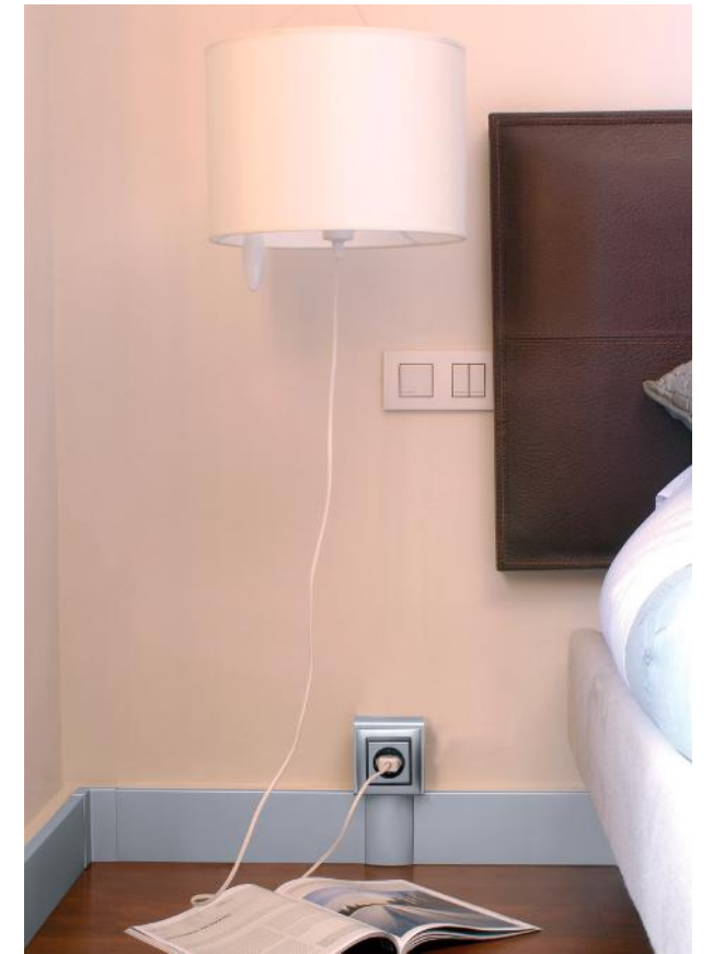
Rehabilitación de viviendas
