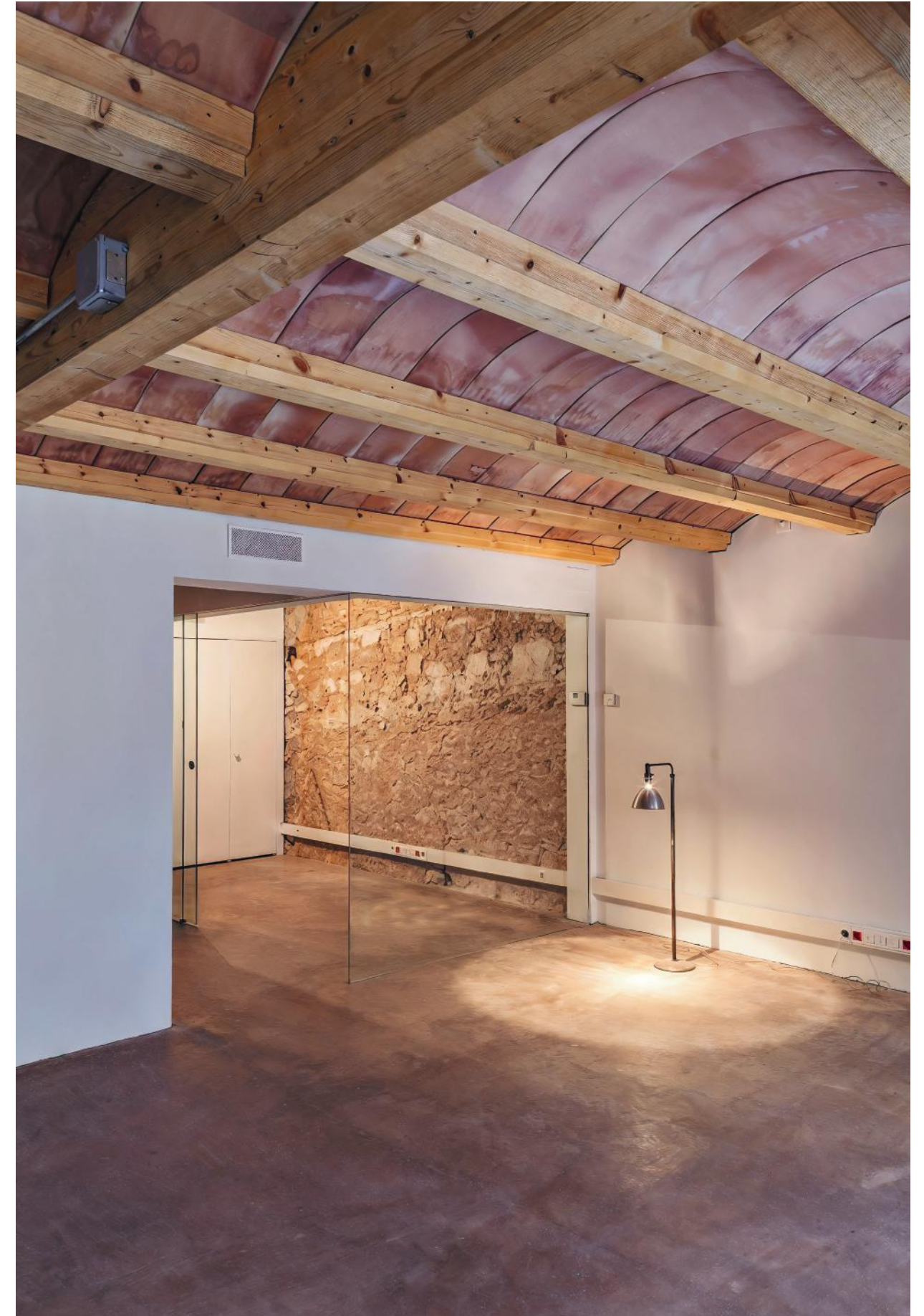
Espacios de trabajo: rehabilitación de oficina
