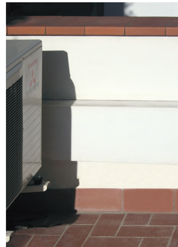
Rehabilitación de viviendas
