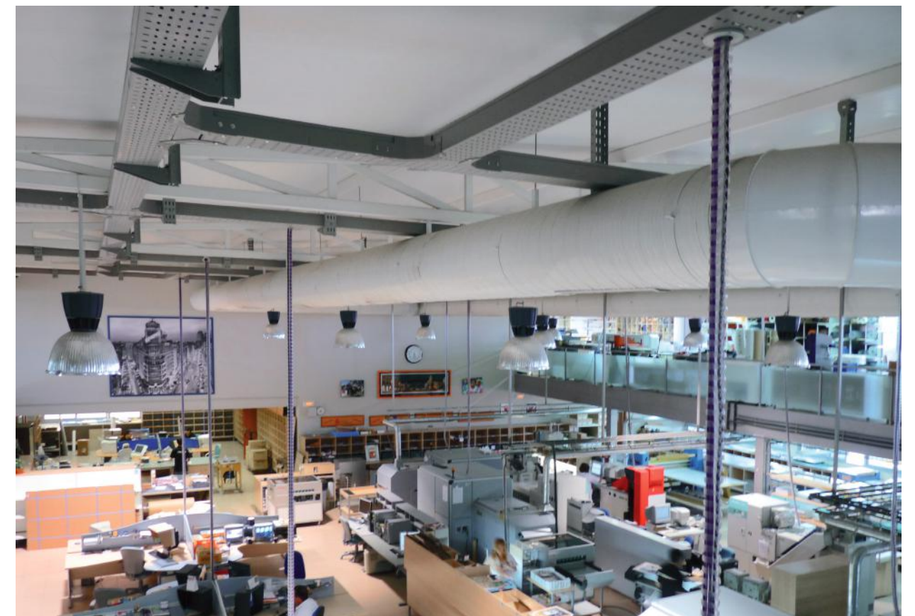
Nave industrial: oficina
