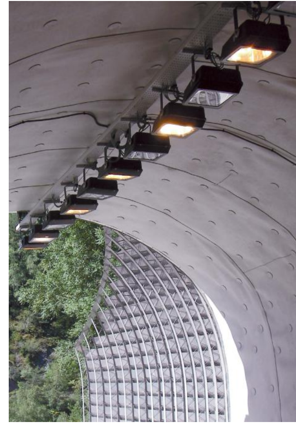
Infraestructura viaria: túnel
