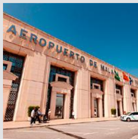
Aeropuerto de Málaga
