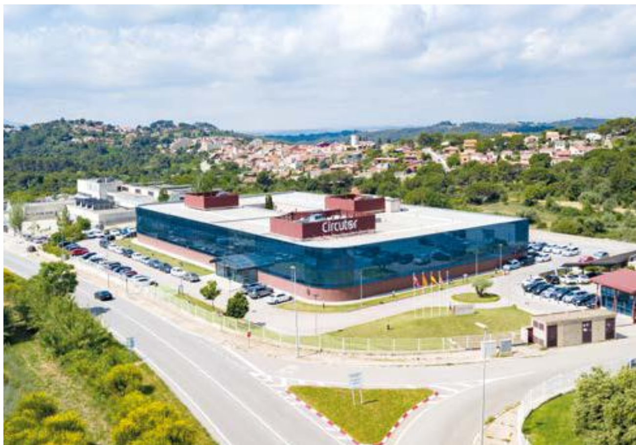
Sede central de CIRCUITOR en Viladecavalls, Barcelona.
