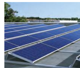
Montaje sobre cubierta plana
