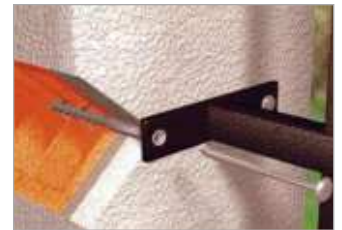
Fijación con taco
